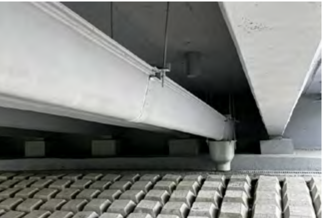
Видео монтаж подвесного водоотвода
